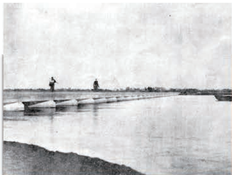
1934年建成的沂河大桥
